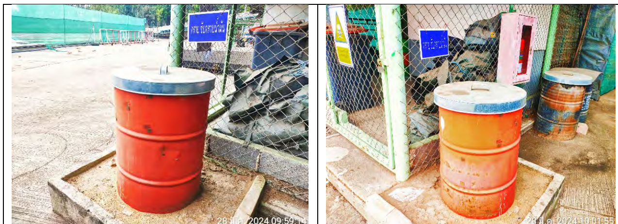
รูปที่ 2.2-33 ถังทรายดูดซับน้ำมัน
