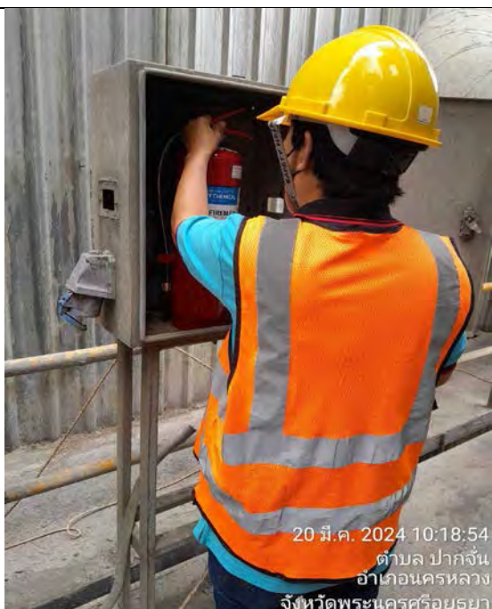
ถังดับเพลิงชนิดผงเคมีแห้ง
