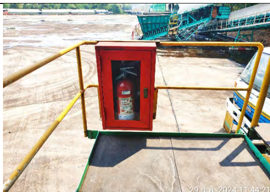
ถังดับเพลิงชนิดผงเคมีแห้ง
