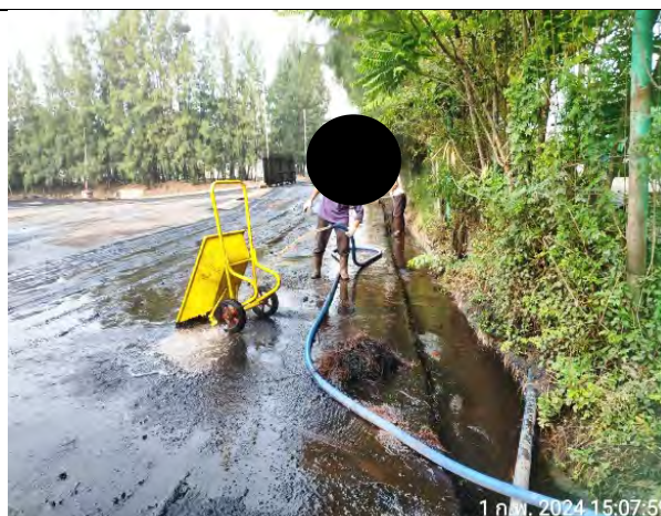
วางระบายน้ำด้านข้างป้อถ้ำล้อรถ 1 (บริเวณพื้นที่กองถ่านหิน)
