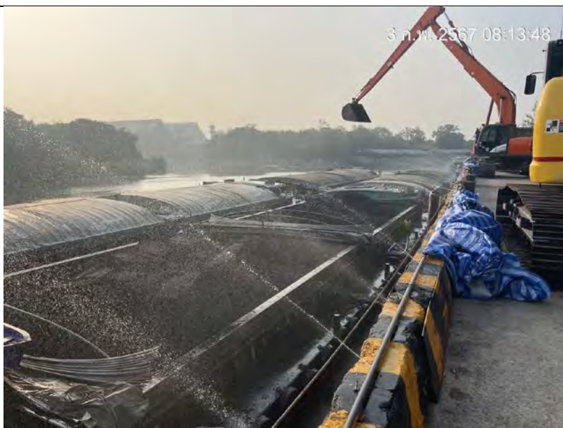
ระบบสเปรย์น้ำบนขอบทำเทียบเรือ
