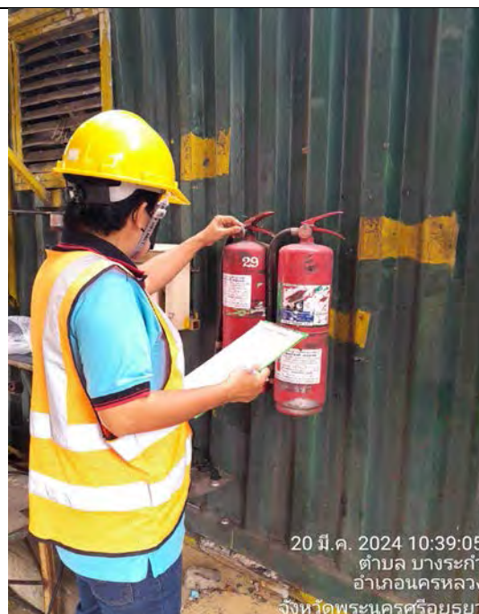
ถังดับเพลิงชนิดผงเคมีแห้ง
