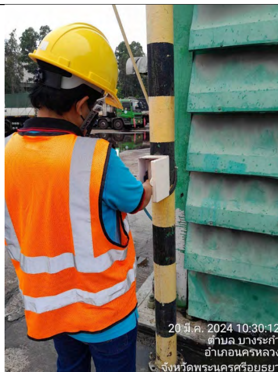
อุปกรณ์ส่งเสียงสัญญาณแจ้งเหตุเพลิงไหม้ บริเวณท่าเทียบเรือที่ 3, 4 และ 5
