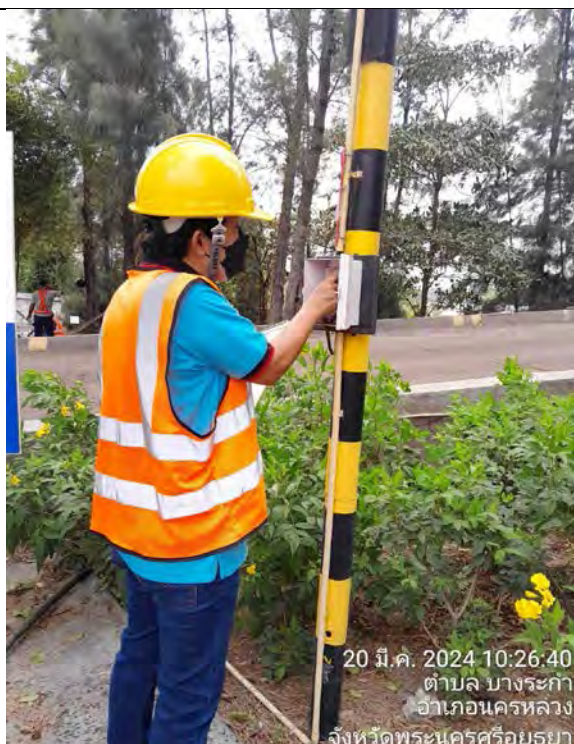
อุปกรณ์ส่งเสียงสัญญาณแจ้งเหตุเพลิงไหม้ บริเวณท่าเทียบเรือที่ 1 และ 2
